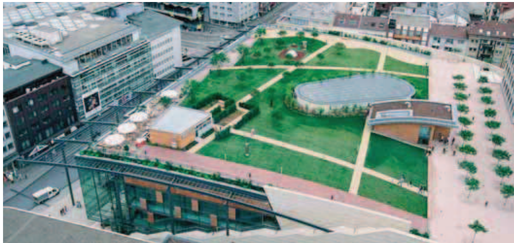
Náročná na statiku je „Parková střecha“ s cca. 700–1 000 kg/m 2
